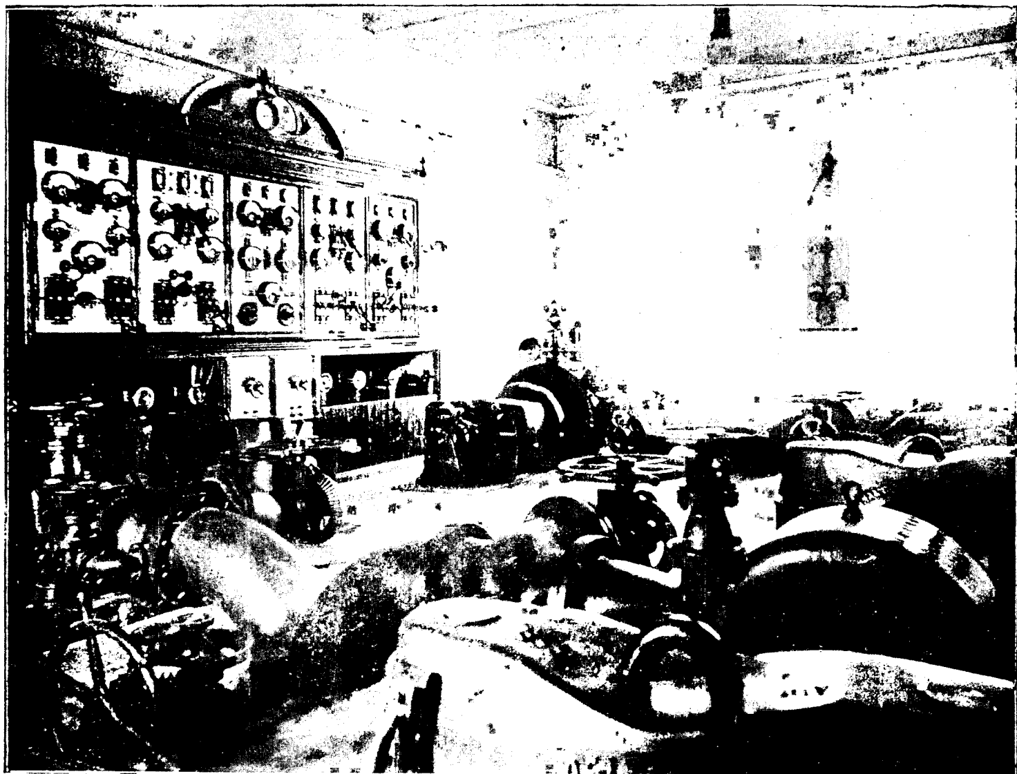
Central de electricidad de Burgos.
