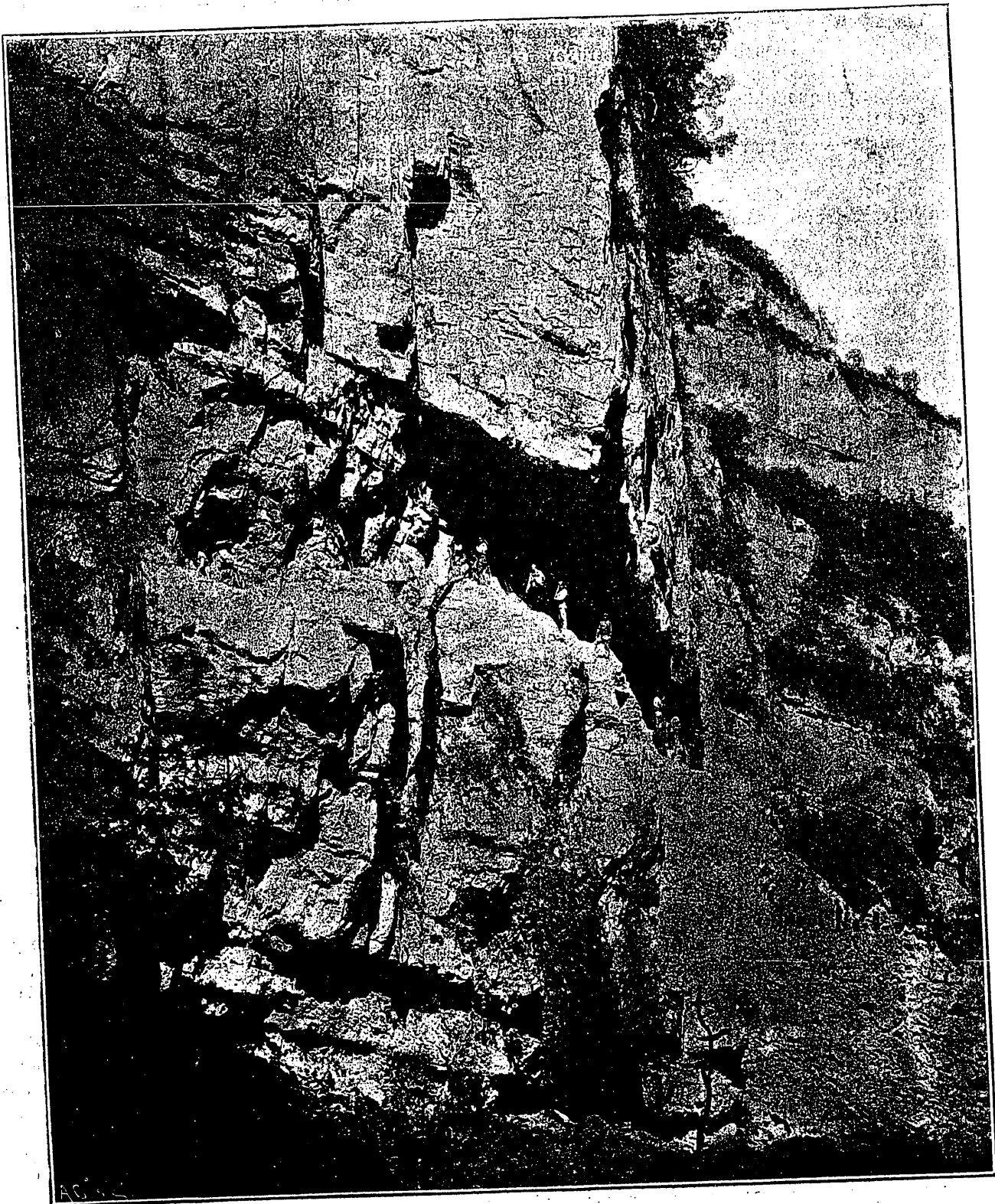
Explanación en trompa en la Foz de Binies — Carretera de Lapeña á Anso (provincia de Huesca).
