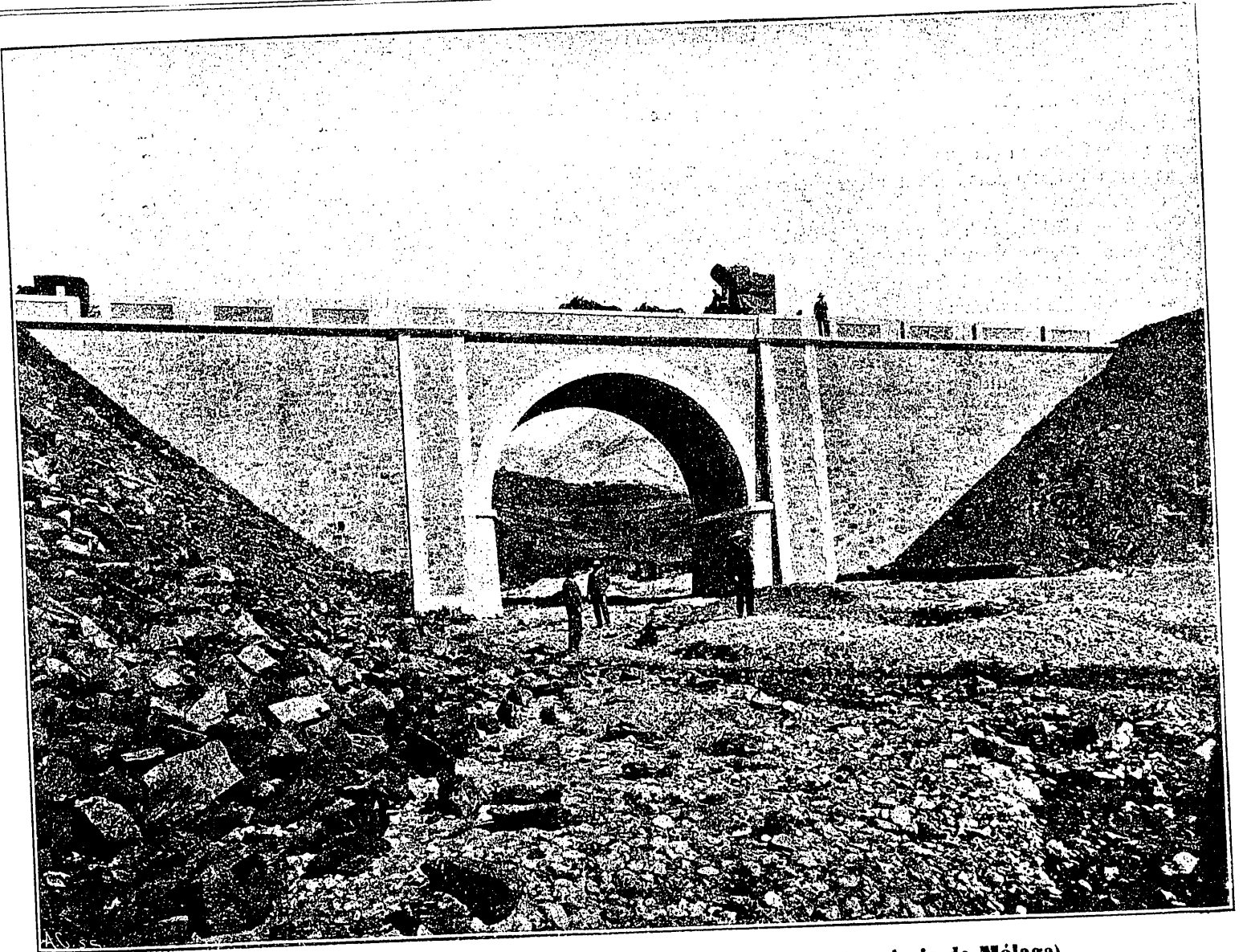
Puente sobre el arroyo Hondo.—Carretera de Cádiz á Málaga (provincia de Málaga).
