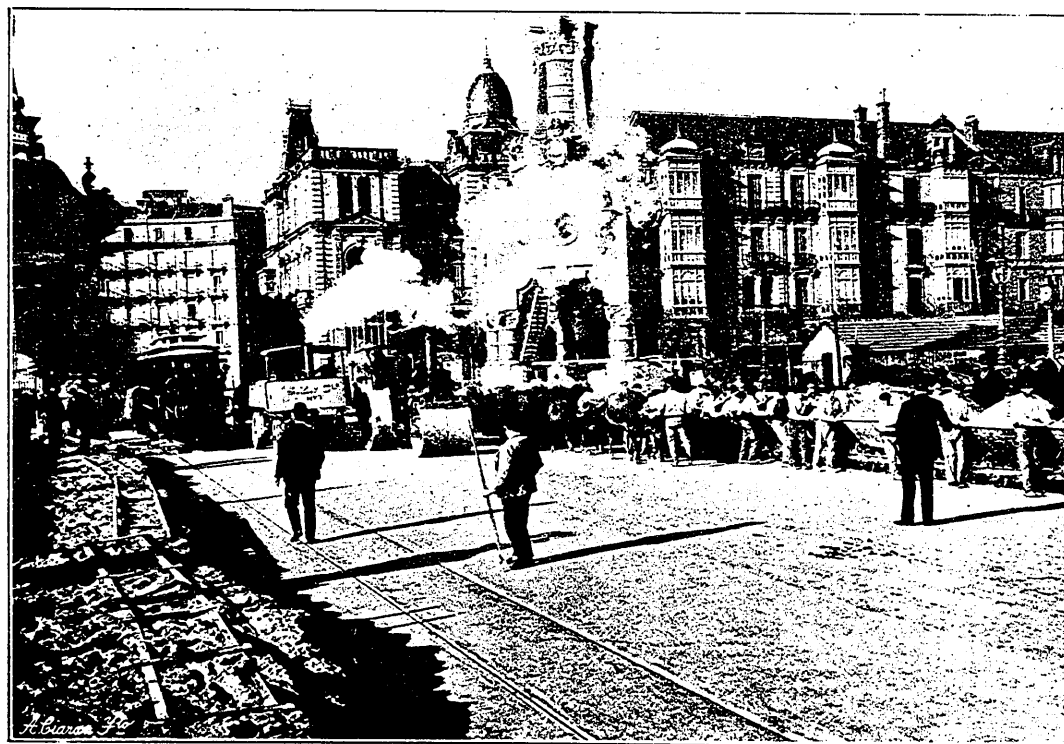
Pruebas dinámicas del puente el día 21 de Diciembre de 1904.
