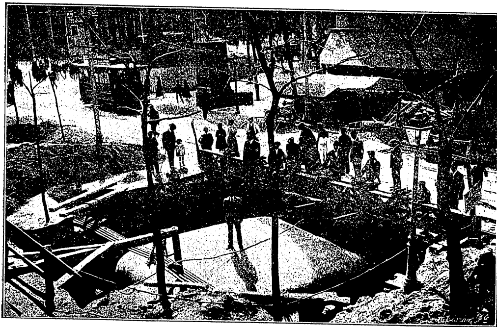
Fig. 10.—Vestíbulo de la estación de la Glorleta de Bilbao (30 de Abril de 1918). Se ha recortado en el terreno la cimbra de la bóveda que cubrirá el vestíbulo.
