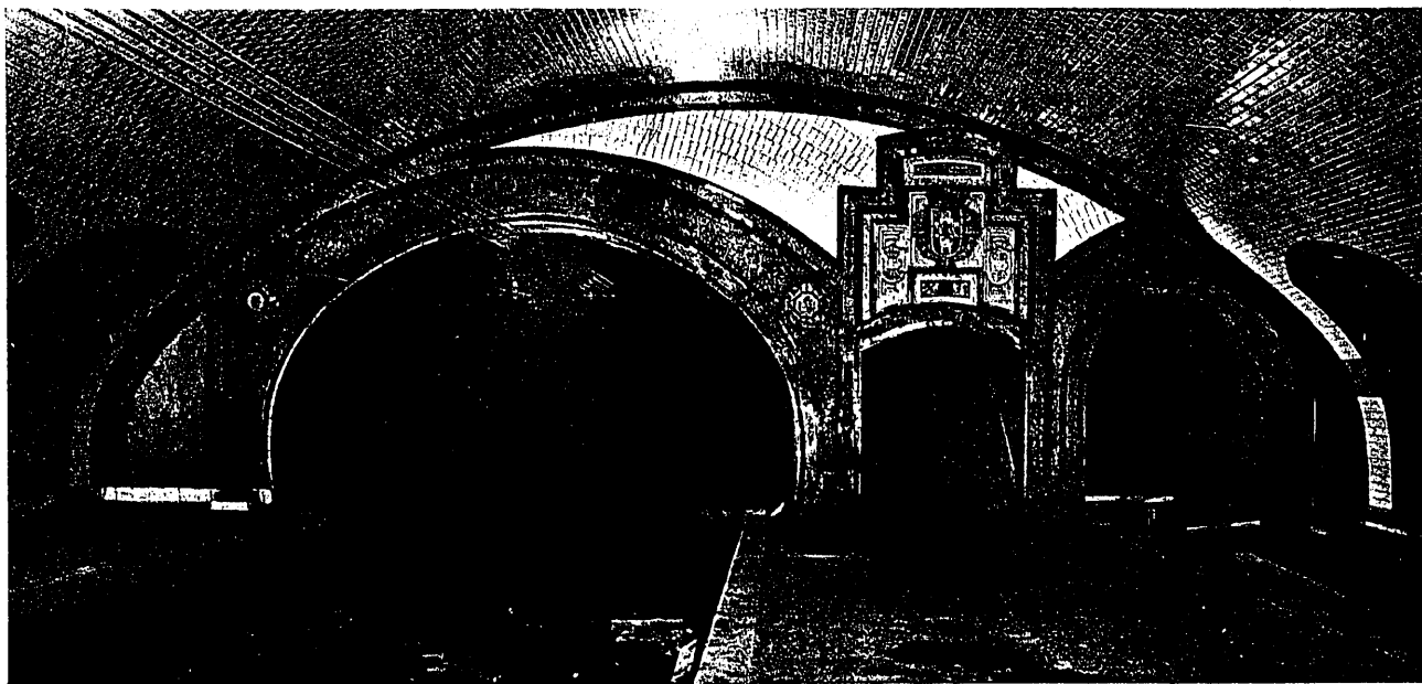
Fig. 1.ª.—Estación del Retiro. Vista del testero Este y las dos vías de la línea Ventas-Sol. A la derecha, la tercera vía para el futuro servicio del Barrio de Salamanca.
