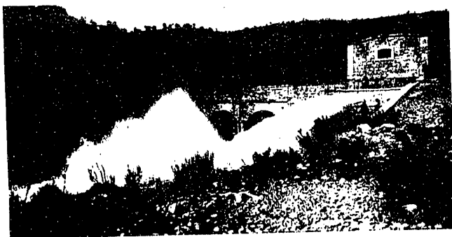
Sifón del Guadalix. Desagüe de fondo
