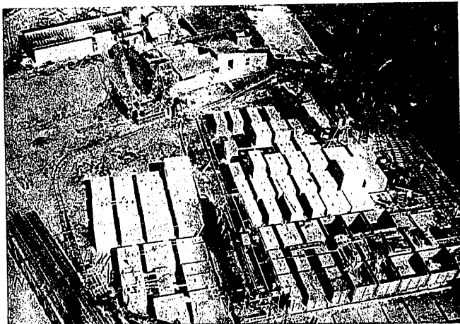
Vista parcial del taller de bloques.
