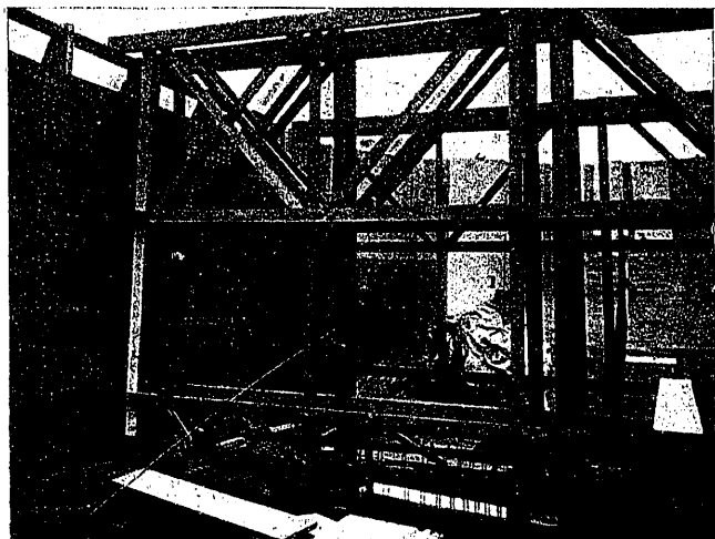
Foto 5. Colocación del encofrado interior.
