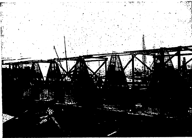
Foto 10. Boyas cónicas en construcción.
