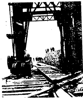
Fot. 1.ª Disposición en que quedó la Titán después del temporal.
