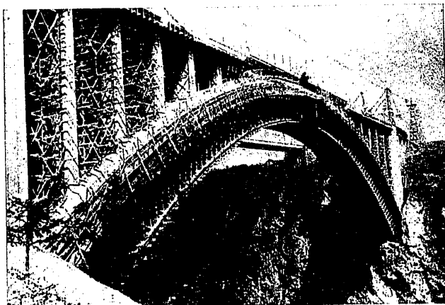
Fig. 9.ª Andamiajes para la construcción del tablero.
