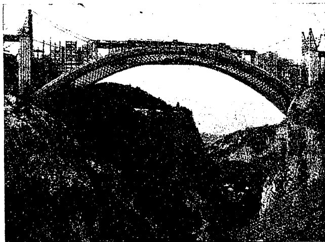
Fig. 8.ª Vista general del puente durante su construcción.
