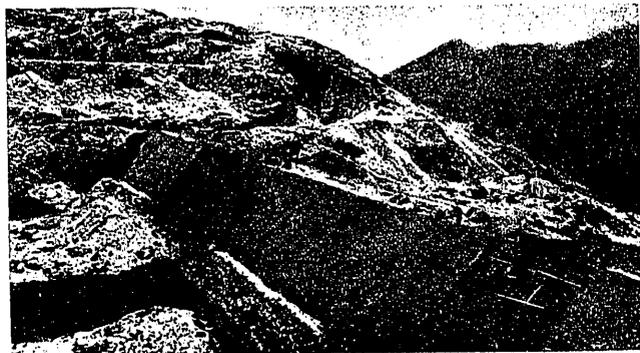
Pantalla impermeable de la presa de embalse del Lago de Urdiceto. Altura de presa, 20 metros. Capacidad del embalse, 5 500 000 m<sup>3</sup>
