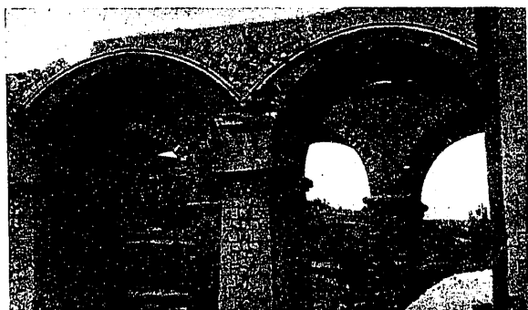
Detalle de arranque de los arcos.
