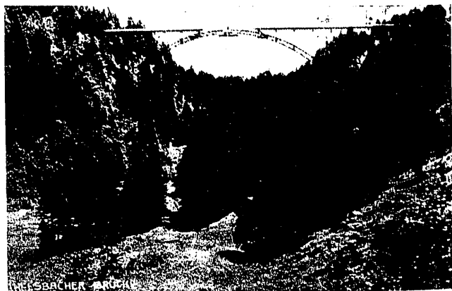
Fig. 5.ª Cierre del arco metálico
