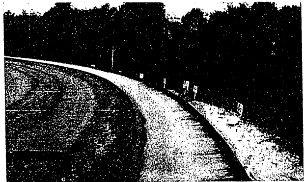
Pista de ensayo en Arlington, U. S. Bureau of Public Roads-Wáshington
