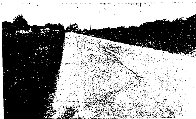
Aspecto clásico de un firme de hormigón hidráulico en el cual pueden apreciarse las grietas rellenas de betún. Provincia de Lucas (Ohio)
