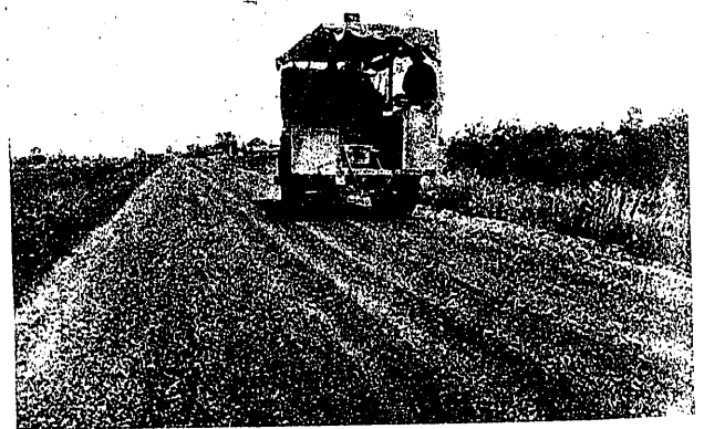
Hormigón bituminoso en frío. Apisonado del firme
