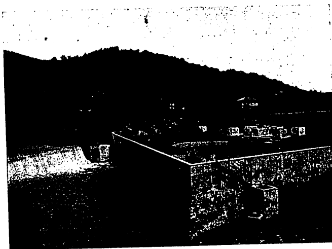
Fig. 8.ª Obras de defensa de la instalación contra las avenidas del río Ibaizábal
