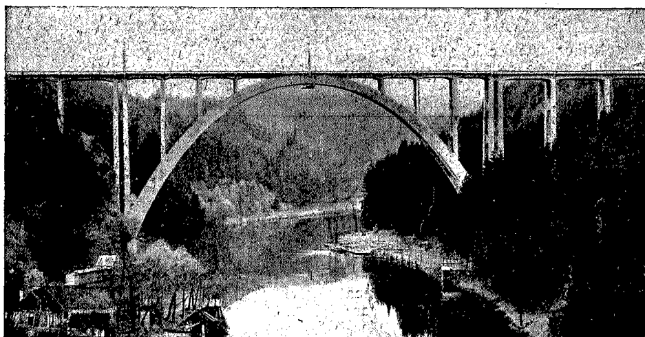
Fig. 3. a Viaducto sobre el Luznice, en Bechyne
