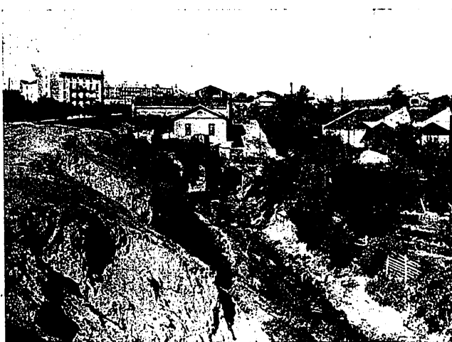
Desviación para el riego del colector de Méndez Alvaro en las inmediaciones de la estación de Atocha, en plena zona urbana.
