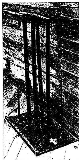
Fig. 15. Disposición de hierros en los apoyos de articulación fija
