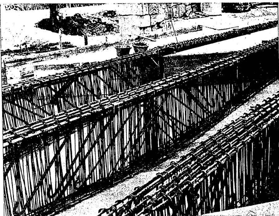
Fig. 9. Armado de las vigas principales en las zonas de los apoyos de articulación fija (Falta ejecutar el zunchado de la zona central)
