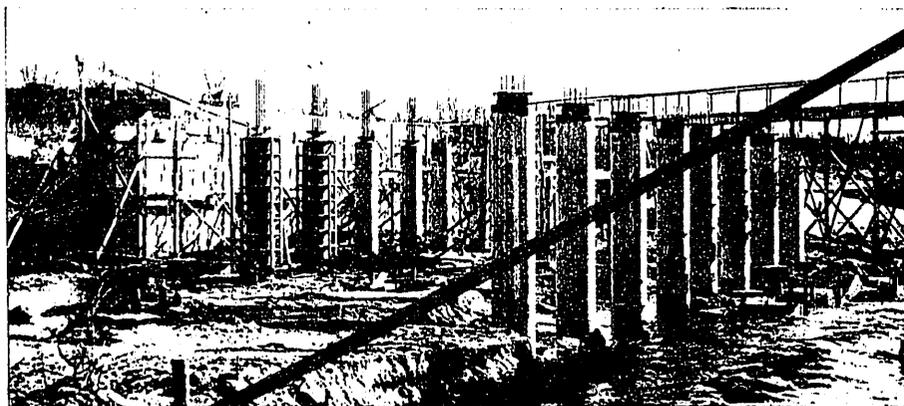
Fig. 6. Pilares del tramo y estribo izquierdo, en construcción
