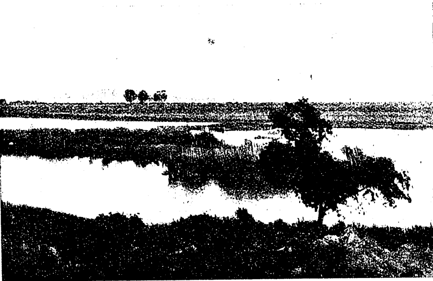
Fig. 2. Sitio donde se construirá la presa de derivación para los canales de las vegas bajas de Extremadura
