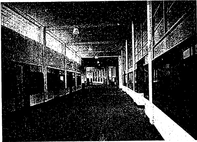
Fig. 33.— Interior del edificio de administración y viajeros del aeropuerto de Berlín.
