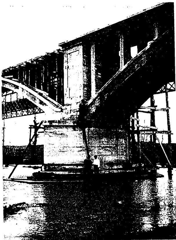
Fig. 5.ª — Pila (a falta de sombrerete), pilastra y arranque de dos arcos; uno de ellos, con los montantes y tablero correspondiente.
