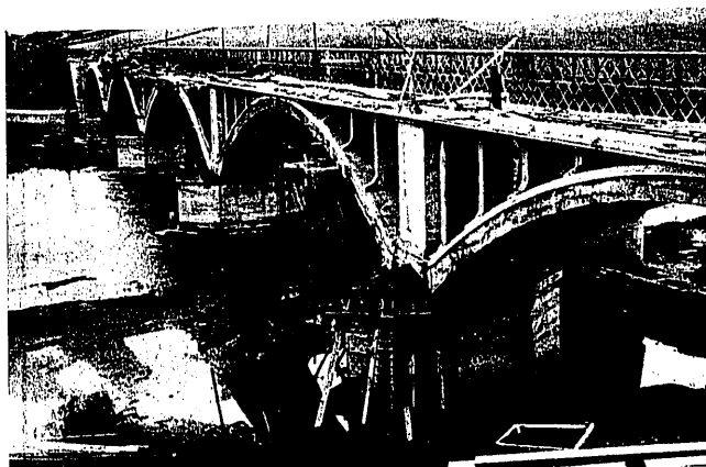
Fig. 6.ª — Vista general del puente casi terminado.
