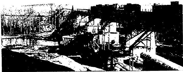
Fig. 4.ª — Dispositivos para hormigonado de pilas desde el puente antiguo. Al fondo, la machina hincando los pilotes del estribo de entrada.
