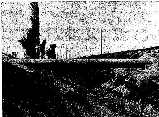
Fig. 2.<sup>a</sup>, b. — Conducción general. Tubo autorresistente para el cruce del canal María Cristina.
