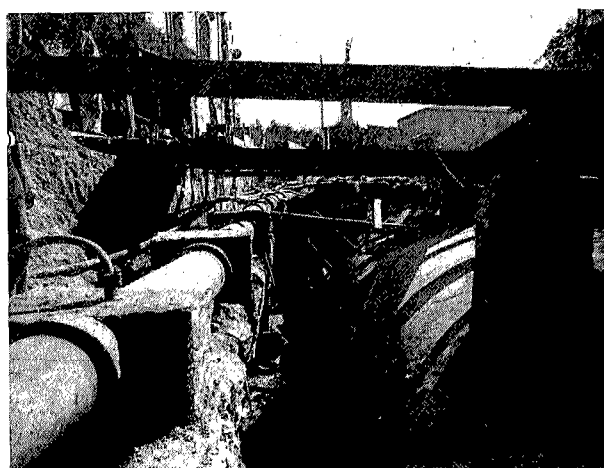
Línea de los Bulevares. A un lado se ve la tubería del Canal, y al otro, el túnel del Metro, construido a zanja abierta.
