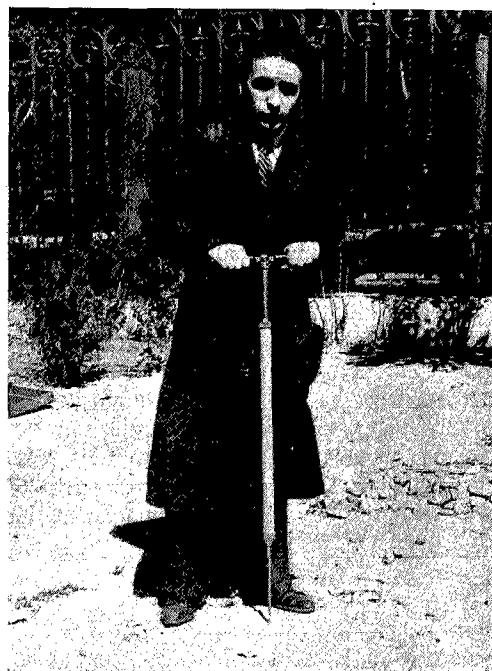
Fig. 29. — Aguja de Proctor.
