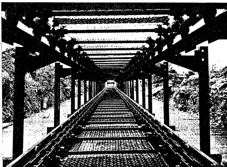
Elevador de maderas. Vista interior de la cinta sin fin.
