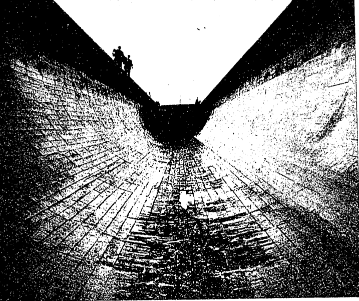
Acueducto de Tardienta, uno de los más importantes de Europa, construido con hormigón armado, para un caudal de 72 m. 3 por segundo.
