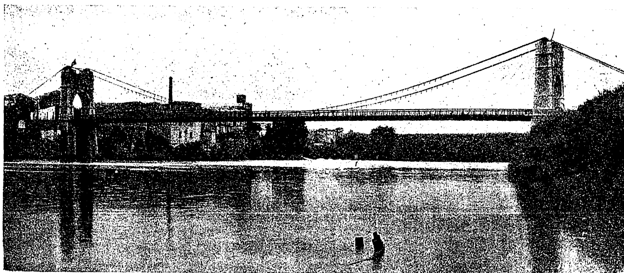
Puente de Amposta.—Terminado e inaugurado en 1941.
