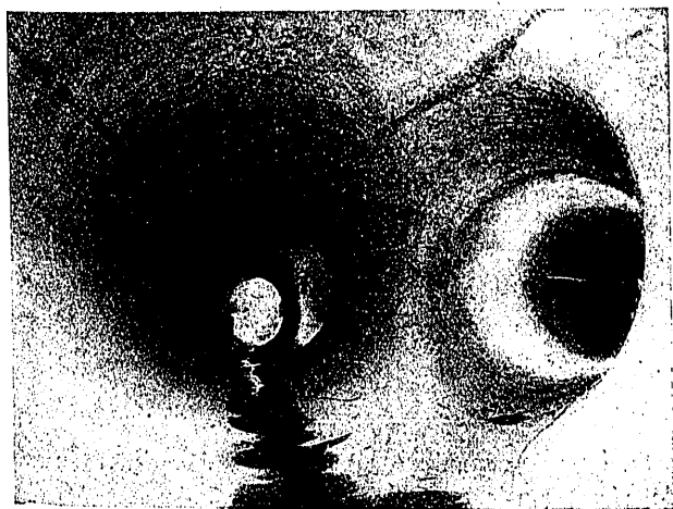
Fig. 13. — Enlaces entre el túnel principal y las tuberías de presión.
