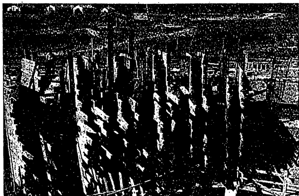
Fig. 12. — Encofrados de los tabiques de la toma
