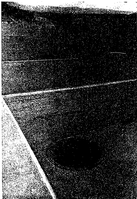
Fig. 14. — Cámara de equilibrio, con los tabiques separadores y uno de los pozos de comunicación con las tuberías.
