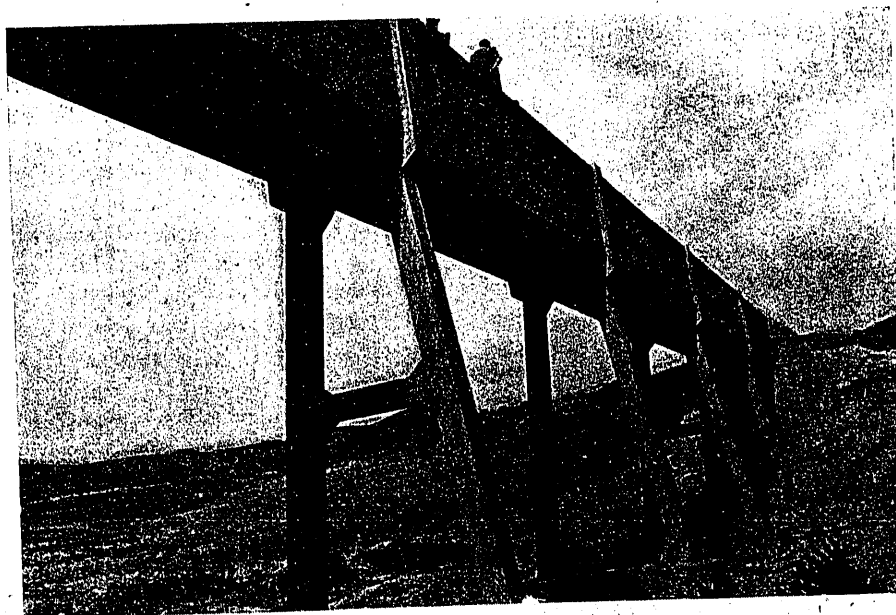
Fig. 12.— Acueducto de siete tramos.
