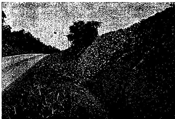
Protección de un talud en una carretera, contra la erosión de las aguas, mediante el Kudzu, que se ha difundido como leguminosa protectora para los suelos erosionados, al mismo tiempo que sirve de productora de pasto y heno. Por sus numerosas raíces, es una planta productora de suelo. El Kudzu iguala en algunos aspectos a la alfalfa, como productora de heno, por su riqueza en proteínas nutritivas.
