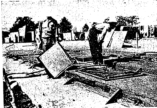
Fig. 18. — Tratamiento por vacío de losas prefabricadas
