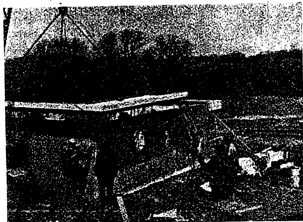
Fig. 22. — Colocación de una losa de techo.
