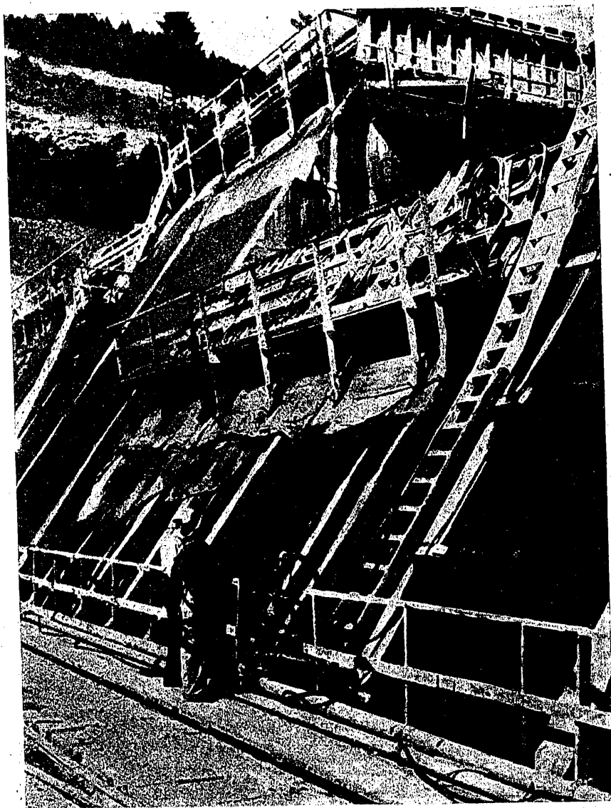
Fig. 16. — Tratamiento por vacío de los paramentos de la presa de Dorena.
