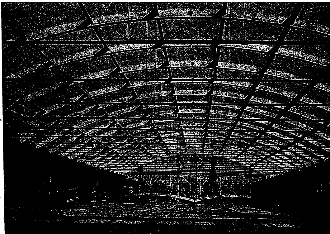
Estructura de la nave central de la Estación de trolebuses de Madrid. Arcos, vigas, viguetillas y losas de forjado totalmente premoldeadas. Arquitecto: Ignacio Fiter. Ingeniero: Carlos Fernández Casado. Luz libre, 45 m. longitud. Empresa constructora: Huerte y Cia.
