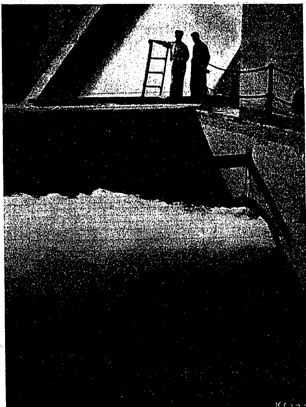
Uno de los desagües de fondo trabajando a plena carga de embalse.
