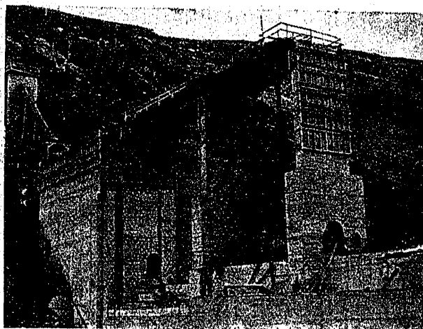
Segundo puente de servicio hasta la cota 232.
