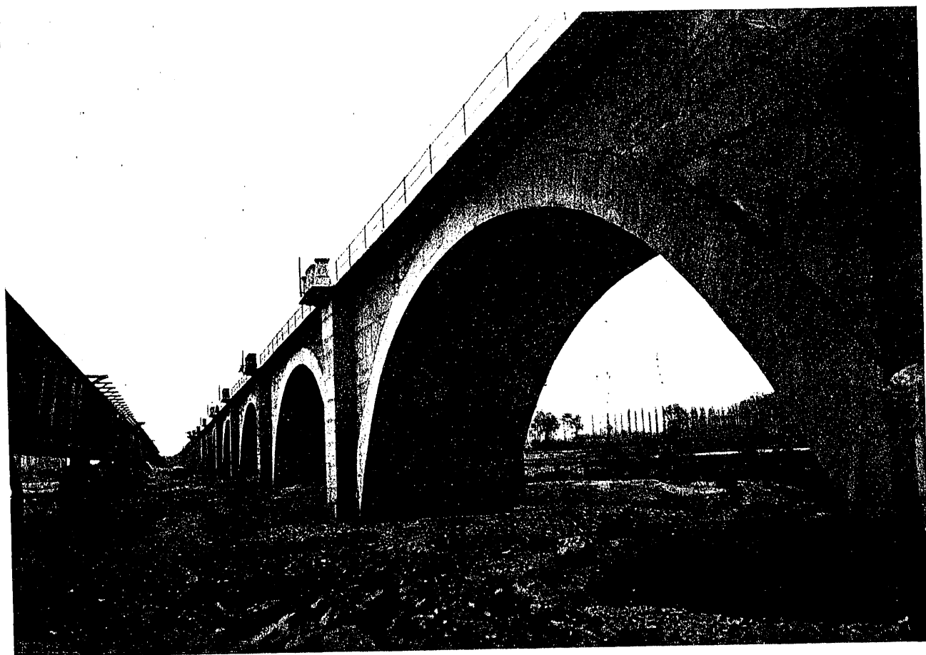
Puente de la RENFE en Marcilla, sobre cajones de aire comprimido. A la izquierda, el viejo puente metálico, sobre cimientos tubulares, también de aire comprimido.
