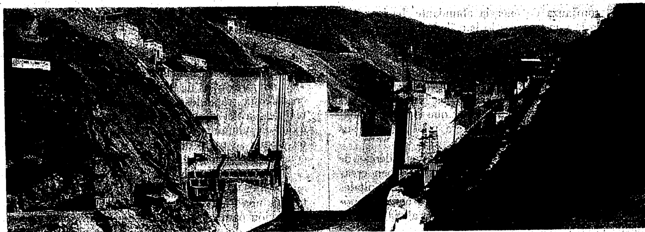
Salto de Peares. Vista panorámica de la presa en mayo de 1953. Potencia de la central, 222 000 CV. Producción anual, 350 000 000 Kw.-h. Entrada en servicio: primer grupo, 74 000 CV., septiembre 1953; segundo grupo, de 74 000 CV., primer semestre 1954; tercer grupo, de 74 000 CV., segundo semestre 1954.
