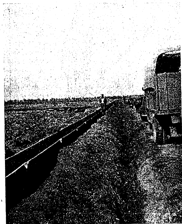
Foto núm. 4.—Acequia prefabricada, dren secundario y camino de servicio de la zona de Relizane.
