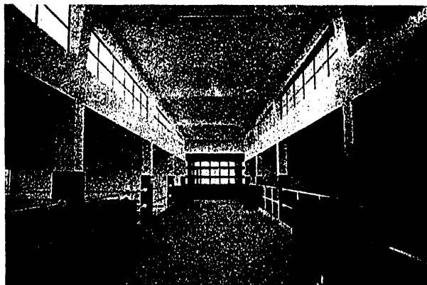
Galería de mandos de los filtros.
