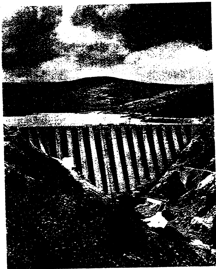
Fig. 4.* — Presa de contrafuertes de Chandreja.
