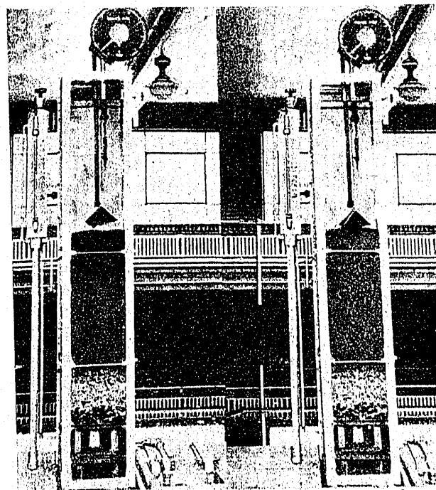
Ensayos de lavado con los Allentown. Los conos miden la expansión de la arena.
