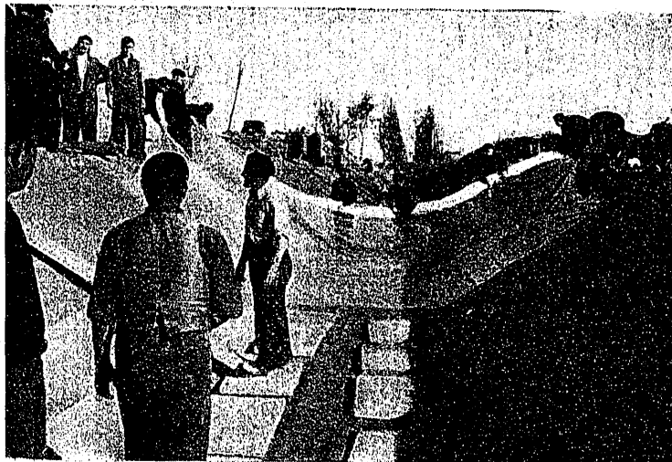
Foto núm. 3. — Tendido de la tela de polietileno.
