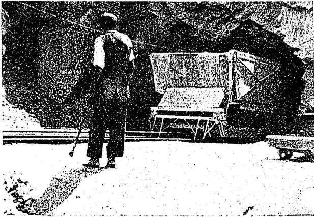
Fig. 5.<sup>a</sup>— Salida de la galería de evacuación de la cantera de Compuerto, con uno de los vagones de 3 m.<sup>3</sup> que transportan la piedra hasta los alimentadores de las machacadoras primarias.
