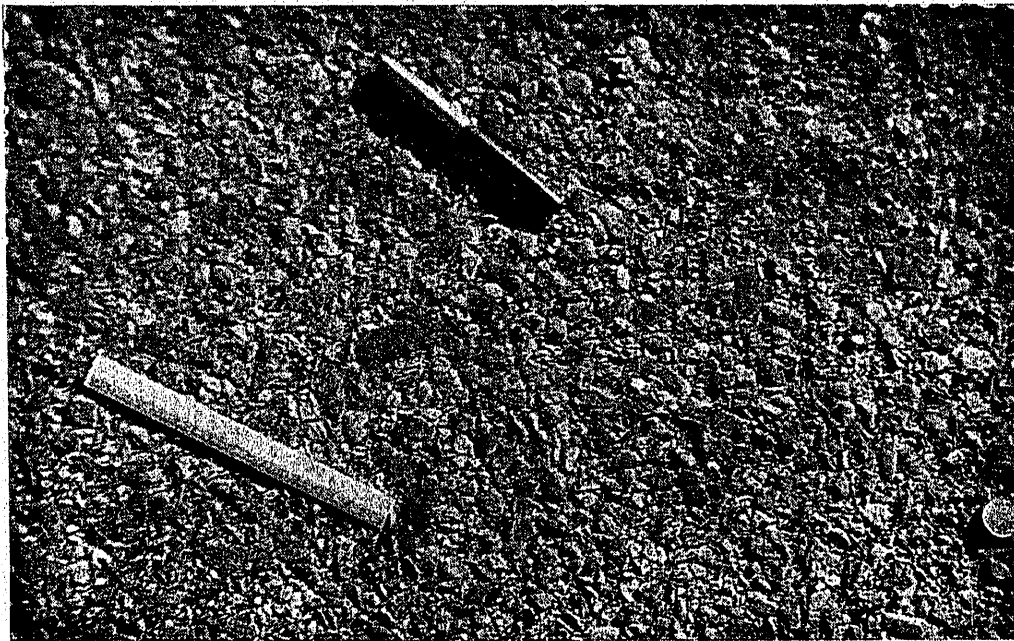
Campaña de 1955. Segundo riego: Carretera R-VI de Madrid a La Coruña, Km. 327. 1,600 Kg. de betún fluido RC-2 y 14 litros de gravilla de 10/16 mm.
