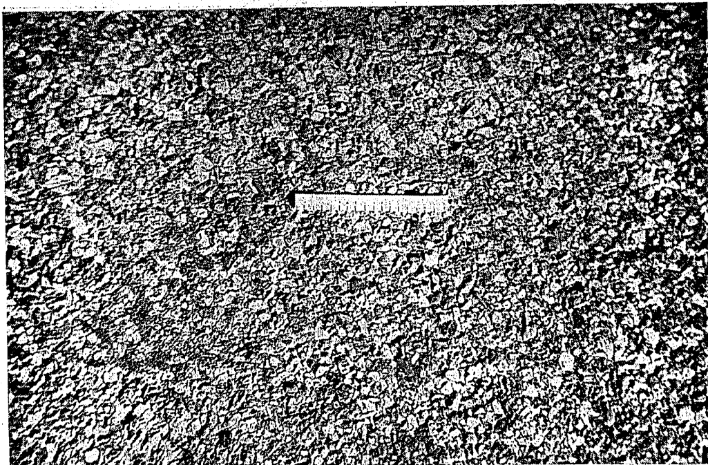
Campaña de 1956. Primer riego: Carretera C-623 de León a Villablino, Km. 9 de la de La Magdalena a Belmonte. 2,500 Kg. de betún fluido RC-2 y 15 litros de gravilla de 8/12, mm. Tráfico: 120 vehículos/día, con un 60 por 100 de camiones; tiempo en servicio, tres años.
