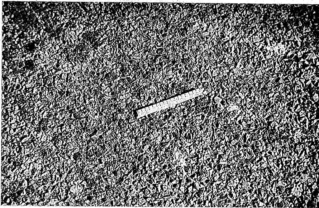
Campaña de 1958. Primer riego: Carretera de León a Caboalles, Km. 39. 3,000 Kg. de betún fluido RC-3 y 18 litros de gravilla extendida en dos fases: 13 litros de 14/18 mm. y 5 litros de 8/14 mm. Tráfico: 100 vehículos/día, con un 50 por 100 de camiones. Tiempo en servicio, un año. El macadam de base estaba en muy mal estado y hubo que hacer un intenso bacheo previo; con el riego se consiguió la regularización del firme. Se hizo en muy buen tiempo.
