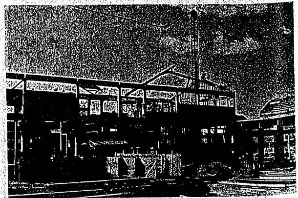
Foto 18. — Montaje de cerchas en el taller de Electrólisis de Española del Cinc, en Cartagena.
