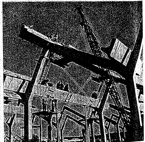
Foto 16. — Montaje de vigas cumbreira en la cubierta de Metalúrgica Santana.
