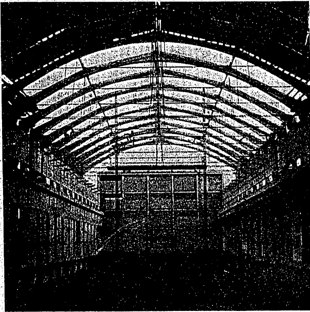
Foto 14. — Ejecución, con dos plumas metálicas, de la cubierta del taller de sulfato en la factoría de Barnús, de SIN.
