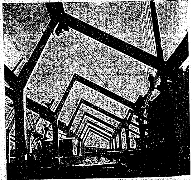
Foto 15. — Pórticos en diente de sierra totalmente prefabricado. Metalúrgica Santana, de Linares.
