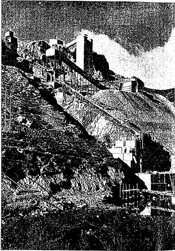
Foto núm. 14. — Presa de Aguilar de Campóo. Excavaciones en el estribo derecho a principio de la cimentación de esta parte. En la parte superior, instalación núm. 3 de hormigonado y silos de cemento.
