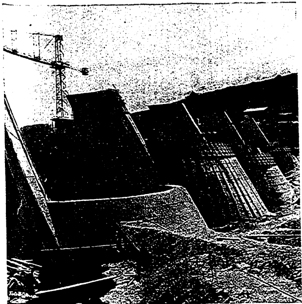
Fig. 5. a — Hormigonado de las bóvedas.
