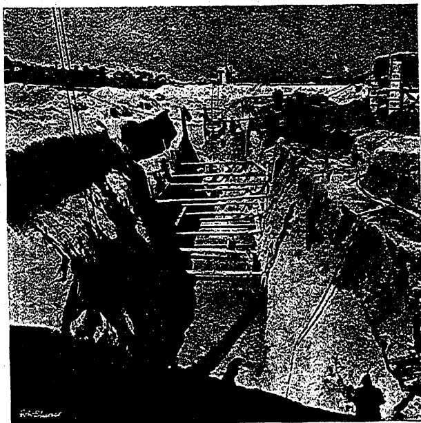
Fig. 1.ª — Hormigonado de la falla del contrafuerte núm. 8.
