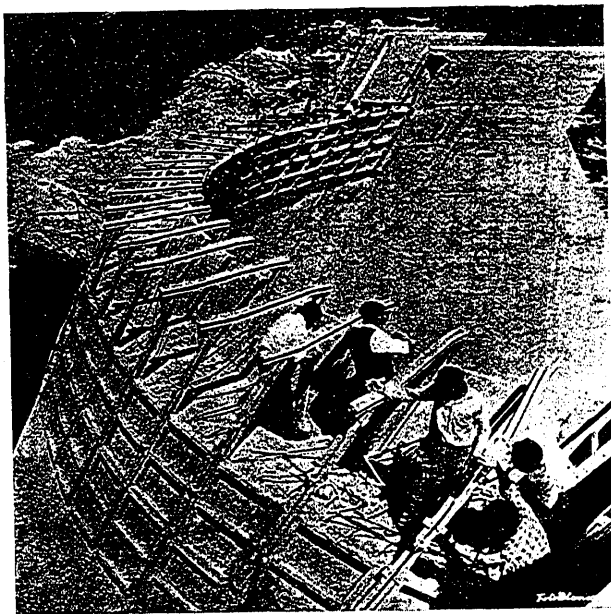
Fig. 6. a — Encofrados utilizados en el hormigonado de bóvedas.
