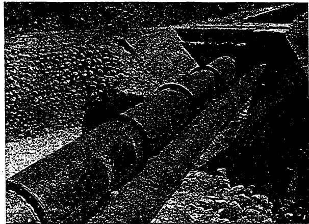
Foto 13.—Las dos tuberías en funcionamiento.
