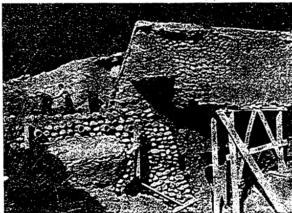
Foto 6.—Elevación del muro para apoyo de tubería.
