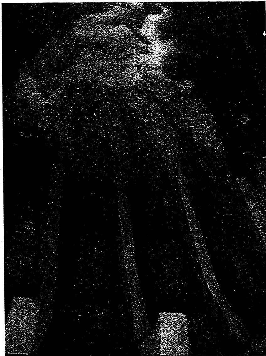
E-69. Presa de Valdeobispo. Aliviadero sobre la central con concentración de caudales que rebaja los 100 m. 3 /seg. por metro lineal. Las ondas producidas por la oblicuidad se eliminan mediante chafanes planos.
