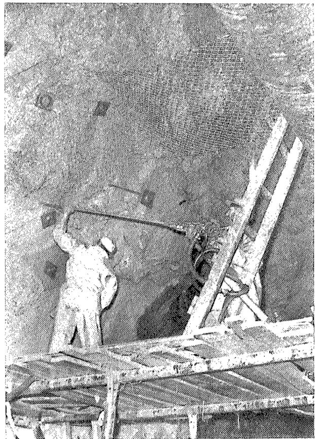
Foto núm. 5.—Galería de presión de Bao-Puente Bibey. Detalle de entibación con cercha metálica y enfilaje de viguetas de hormigón. El relleno contra la roca es también de viguetas de hormigón. Separación de cerchas, 75 cm.
