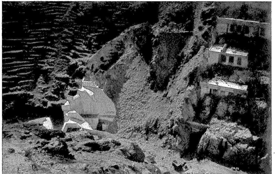
Foto 2.— Ataguía de la presa de Bao. Photograph No. 2.— Bao Dam cofferdam.
